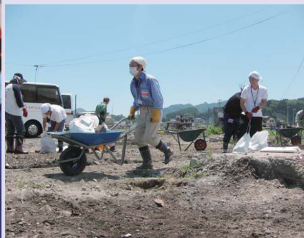
がれきや側溝の泥撤去作業
